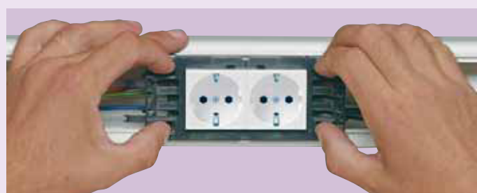
Монтаж розеток Mosaic в кабель-каналы DLP
