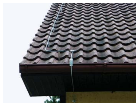
Токоотвод, смонтированный на черепичной кровле
